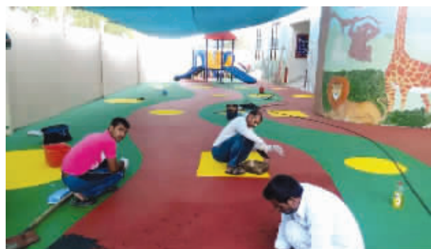
凭借优质的性能，优冠的产品远销海外多个国家和地区。图为工作人员在迪拜一幼儿园内施工。
