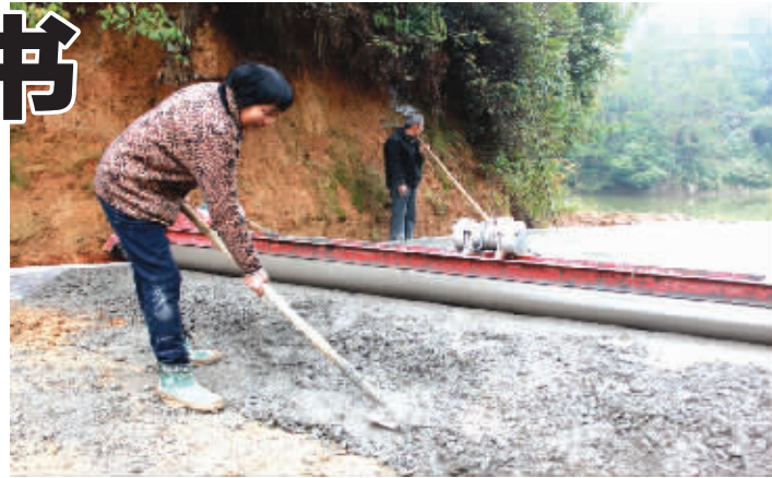
罗金莲在修路工地上劳动。
