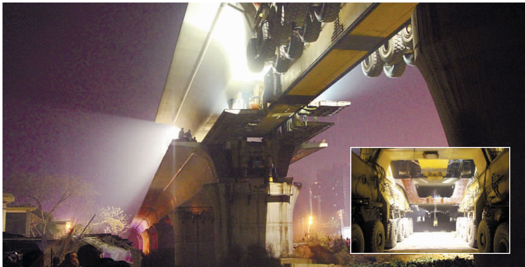
1月3日凌晨1时20分,在湘潭市护潭广场附近,经过现场40多名架梁作业人员约3个小时的奋战,运架一体机将长株潭城际铁路湘潭段最后一孔900吨箱梁精准架设就位,这标志着由中国铁建二十五局集团一公司施工的湘潭段架梁圆满贯通。小图为对接处施工情景。 记者 叶子君 通讯员 欧正清 周全 摄
