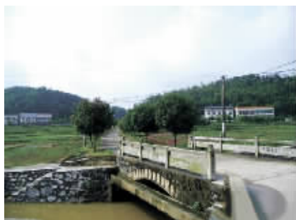
静静守候的罗家坝桥。
