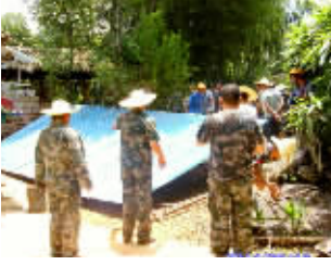
▲拆违控违现场
