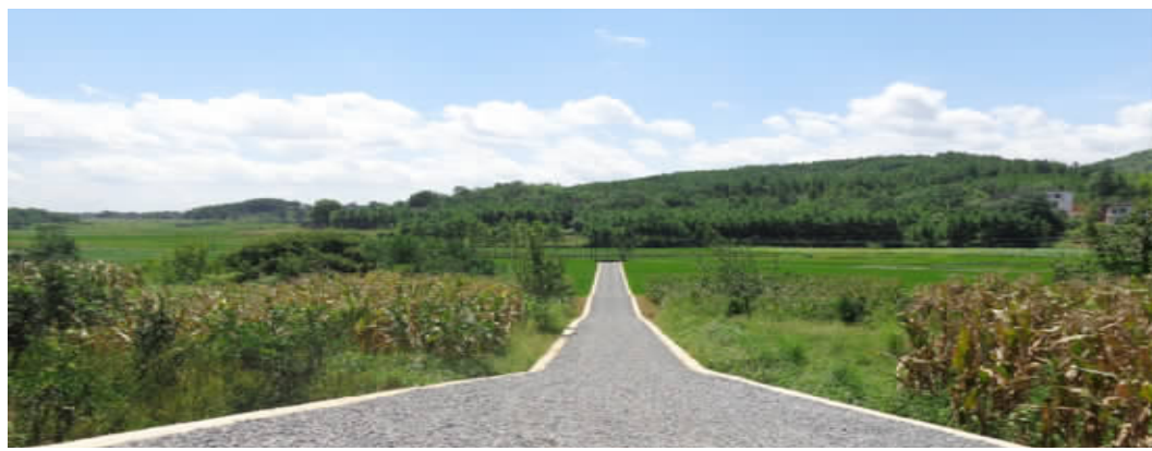
▲土地整治项目
