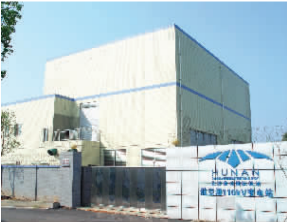
公司承建的黄花国际机场航空港110kV变电站
