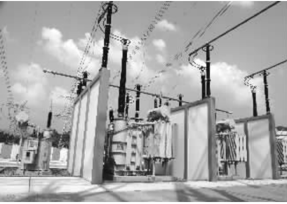
牌楼500千伏主变扩建
