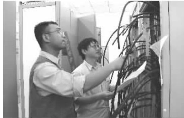
变电站保护设备安装
