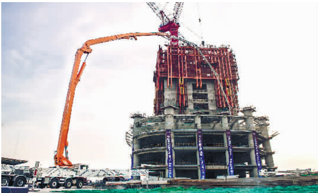
中联重科101米长臂架泵车在武汉施工。(资料图片)
