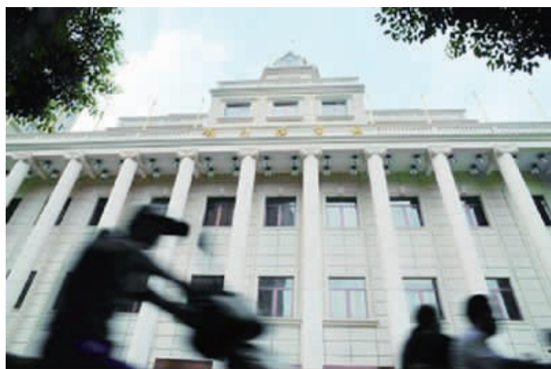
长沙市中山路，行人从被修复一新的“国货陈列馆”前经过。记者 田超 摄
