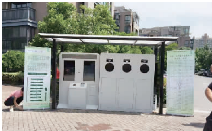
工作人员正在安装智能垃圾分类器。
