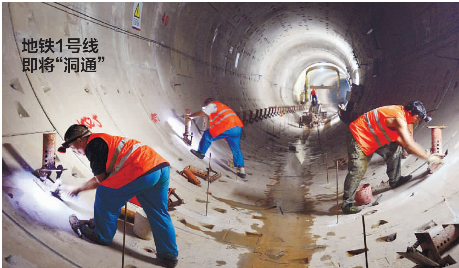
9月14日,建设工人在安装铺设门吊走行轨。当天,长沙地铁1号线铺轨工作进入侯家塘站施工,全线有望近日实现“洞通”。预计2016年开通试运营。 记者 李健 摄
