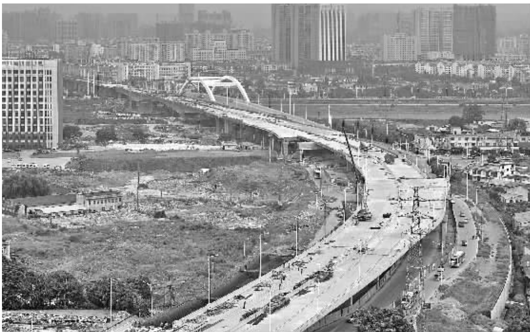
8月16日,长沙市万家丽路快速化高架主线贯通,预计国庆节实现竣工通车。 记者 李健 摄
