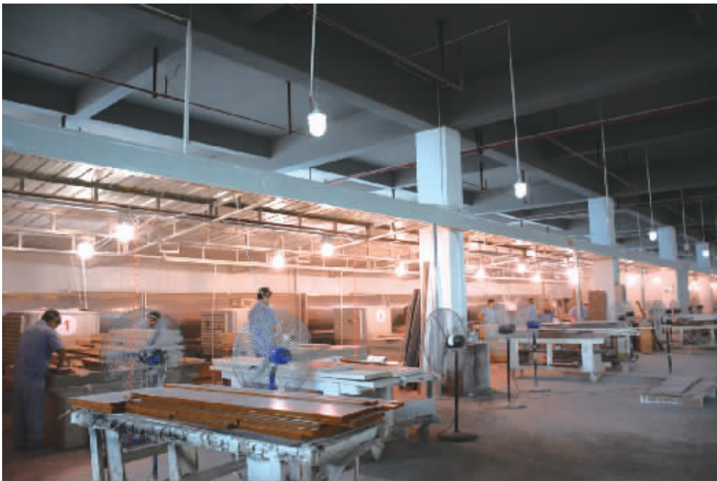
环保材料加上机械化施工,才能真正减少装修现场的有害物质排放。
