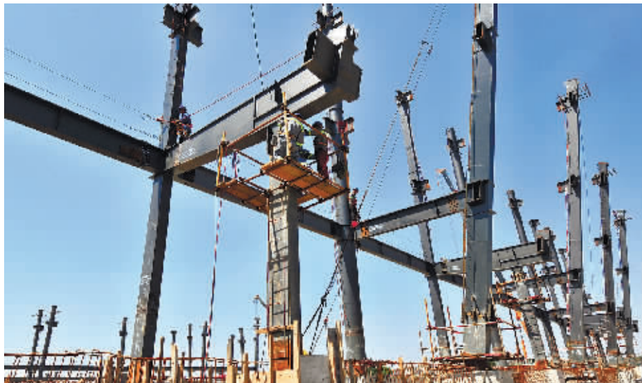
7月30日,长沙国际会展中心建设工地,工人在吊装加固钢结构。记者 田超 摄
