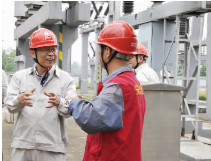
在变电检修现场,张斌(左)与同事交流工作经验。
