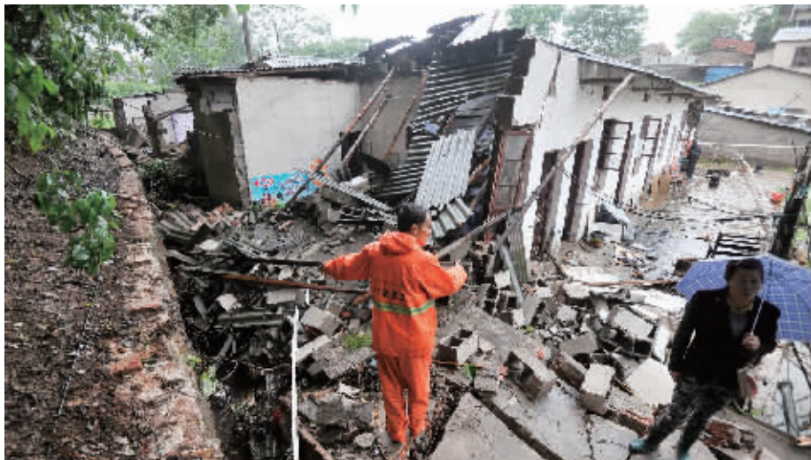
5月11日上午,长沙市南郊公园北侧的楠竹村,被倒塌围墙压坏的房屋破损失惨。记者 田超 摄
