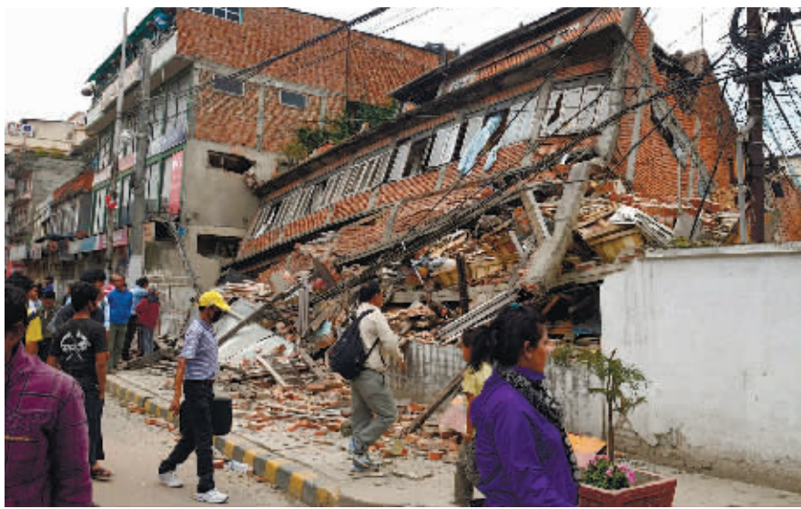
4月25日，在尼泊尔首都加德满都，人们走过一处倒塌的建筑。 新华社图
