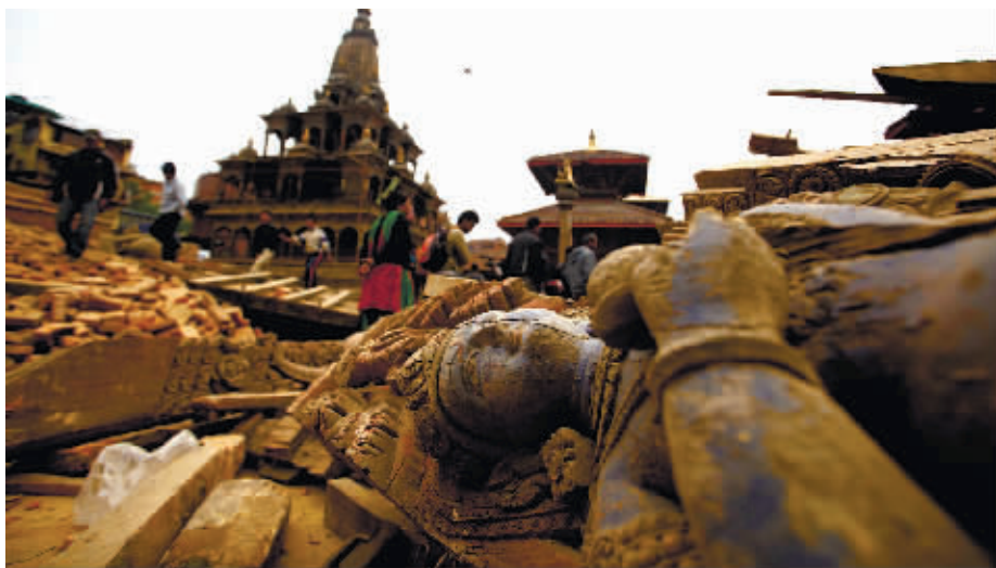
4月26日，尼泊尔杜巴广场佛像倒塌，一片狼藉。 新华社图
