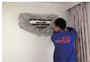
安装清洗套及排污管,用于储存污水
