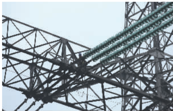
高空停电检修。
