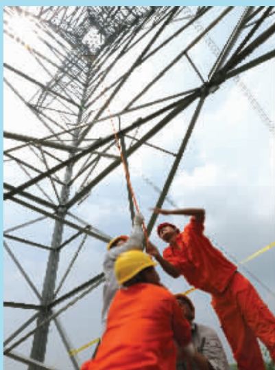
齐心协力开展特高压停电检修。
