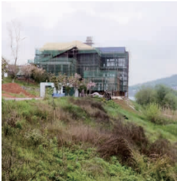
株洲湘江大堤上建起了游客中心,有市民担心施工导致大堤受损,称往年洪水常漫到桩基处。 记者 李永亮 摄
