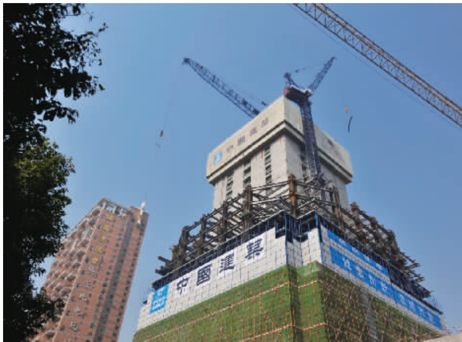
长沙市解放西路正在兴建湖南第一高楼。
