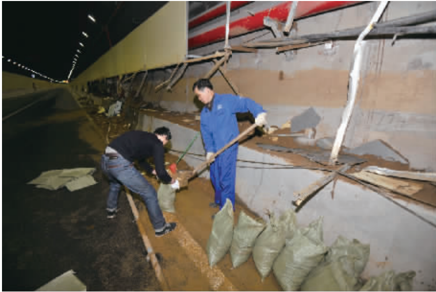
3月24日上午,长沙市南湖路湘江隧道南线西往东方向部分侧墙及附属设施受损严重(右图),工作人员正在事故现场抢修(左图)。 记者 田超 摄
