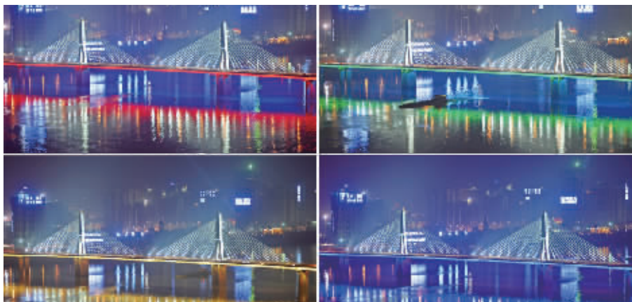
12月29日晚,长沙市银盆岭大桥,不断变化的红、绿、黄、蓝四色洗墙灯,与湘江两岸的绚烂夜景相互映衬。 记者 李健 摄
