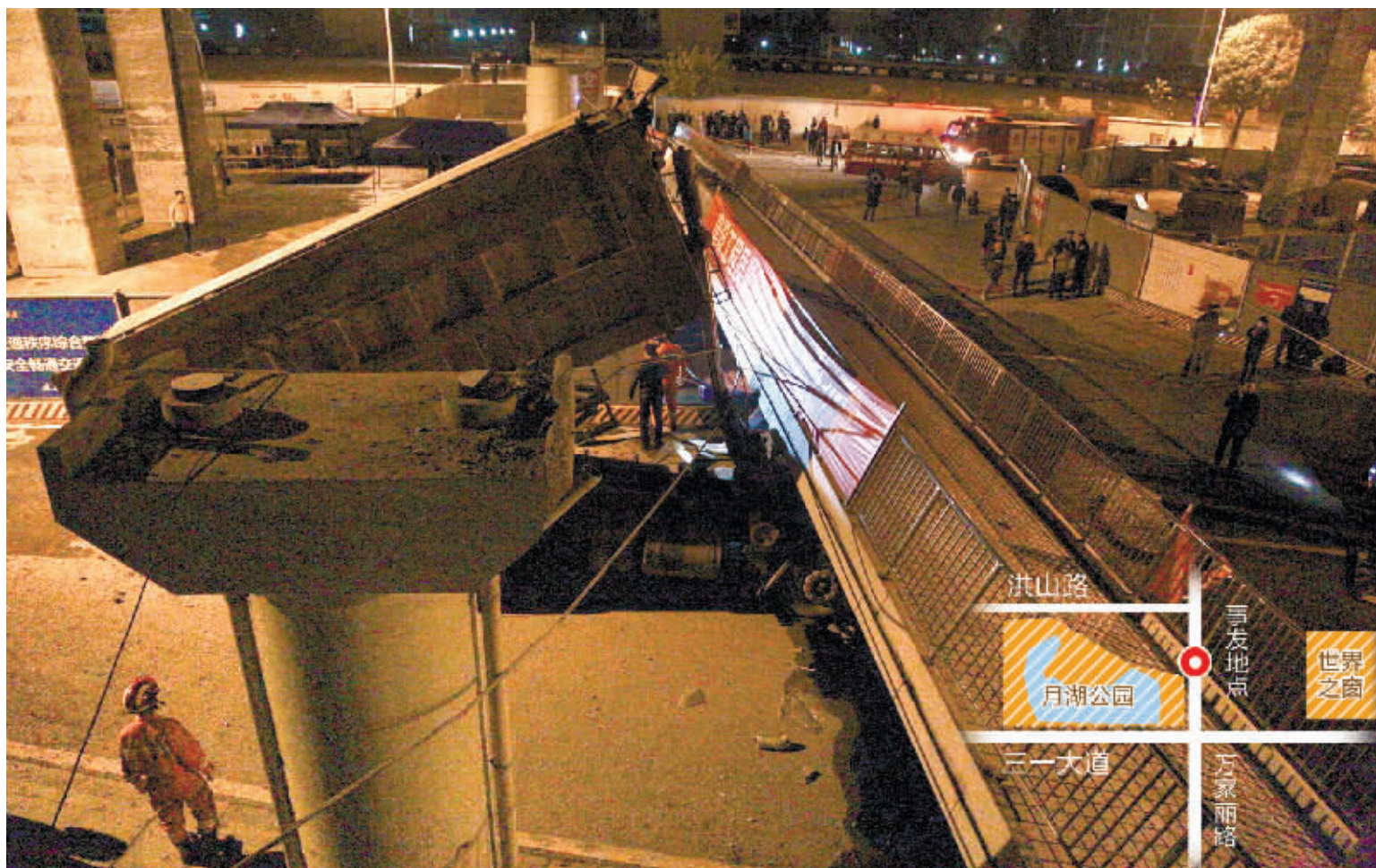
17日晚10点,长沙市开福区万家丽路北往南方向,月湖公园附近,一辆渣土车车头被压在了一座人行天桥下,整个天桥成倾斜式垮塌,司机身亡。交警表示,事故原因是司机没有把货厢放下,撞到天桥,导致桥体移位垮塌。大湘网供图
