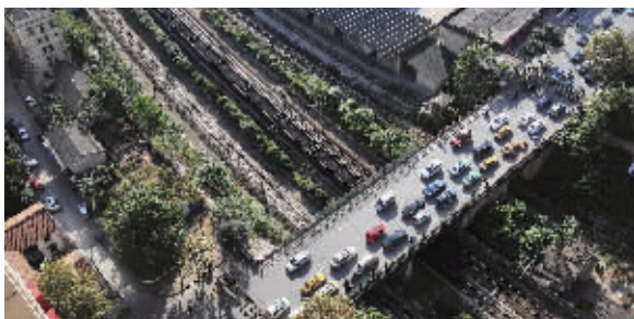
11月3日,长沙市劳动路跨京广铁路桥即将拓宽重建。记者 田超摄
