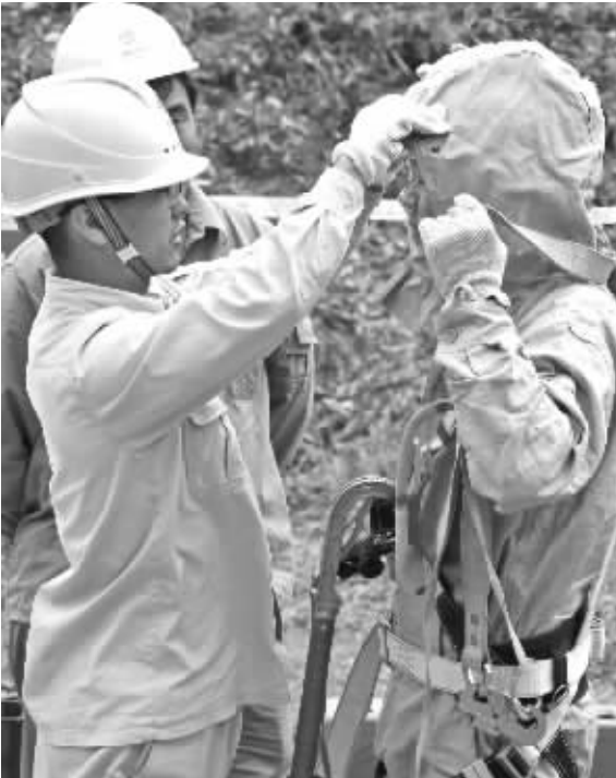
带电作业人员在工作把关人等的严格监督、检查下，仔细披挂完毕，随时准备登塔作业。
