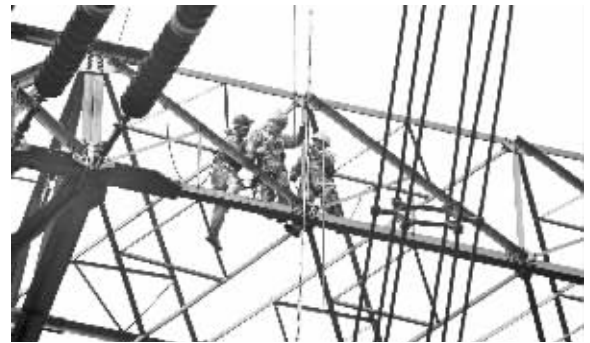
带电作业人员在塔上监护人员的帮助下进入强电场。
