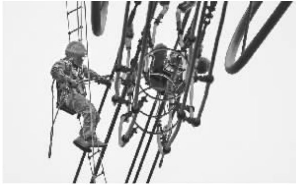
等电位带电作业人员利用电位转移棒进入800千伏特高压强电场作业。
