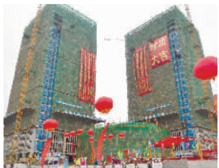
柏宁地王广场写字楼正式封顶。
