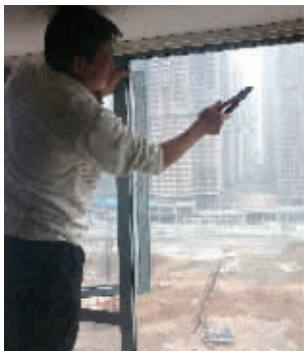
工人师傅正在拆除张先生家开裂的飘窗玻璃。记者 陈月红 摄
