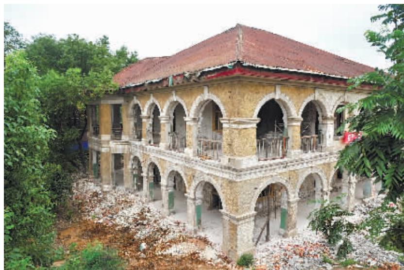
9月18日,长沙市橘子洲,维修中的长沙海关公廨旧址。记者 田超 摄
