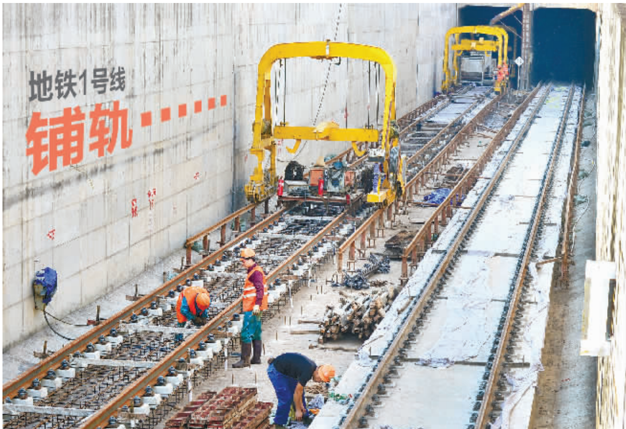
9月12日,长沙地铁1号线施工人员在安装好的轨排中间浇筑道床。目前,长沙地铁1号线已完成中信广场站至尚双塘高架站900米轨道铺设。这标志着长沙地铁1号线轨道工程正式进入轨道施工阶段。长沙地铁1号线计划2016年通车。 记者 李健 摄
