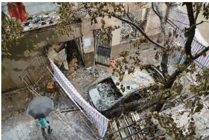
附近居民在起火的仓库边察看损失情况。实习生 任梦龙 记者 田超 摄
