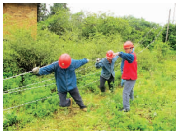
服务队现场施工。
