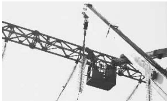
工作人员在长沙220千伏楠竹塘变电站顶高温扩建。
