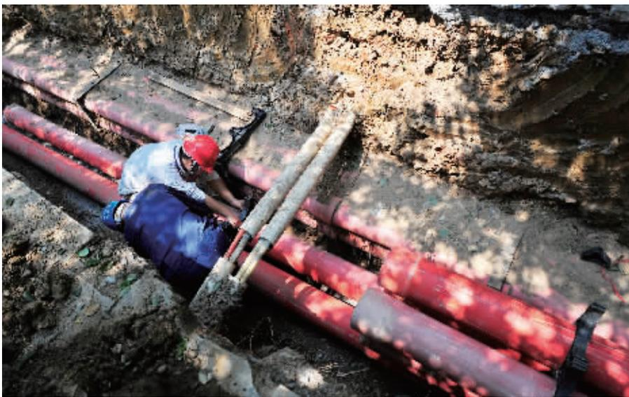
7月31日，长沙市马王堆南路，工作人员在110万伏供电线路管网改造工程现场铺设PVC电力管。
