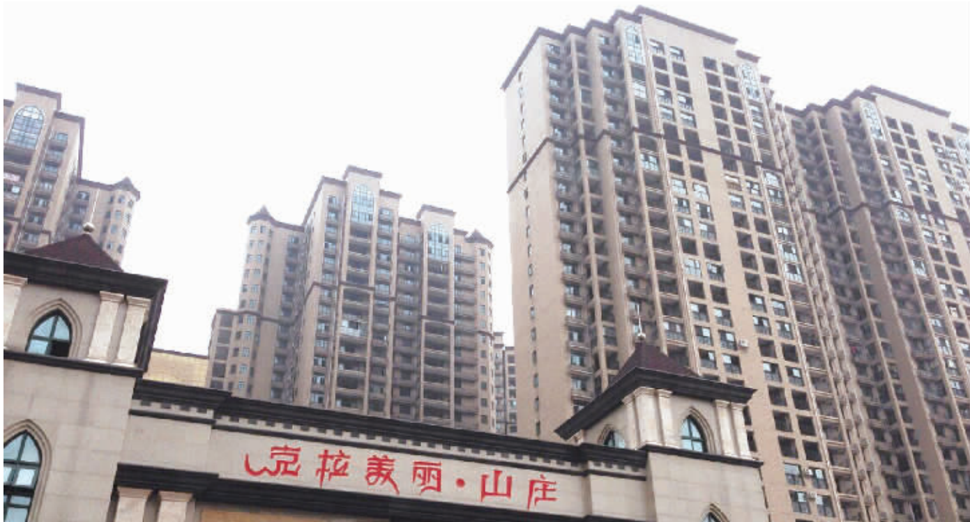
克拉美丽山庄已经交房,部分业主正在装修。
