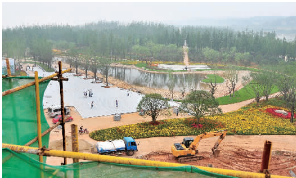
长沙市岳麓区巴溪洲水上公园建设工地，工作人员正在进行绿化施工。
