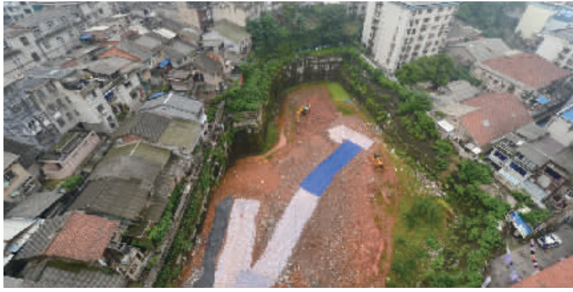
近日,长沙市劳动广场附近一处“大坑”开始回填土,此坑因5年一直没有施工,导致周围27户居民房屋出现开裂等安全问题。 记者 郭立亮 摄
