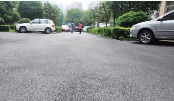
在长沙市岳麓区英才园小区丰颐苑,原本坑坑洼洼、裂缝蜿蜒的路面已经修整一新。 记者 杨仕凡 摄
