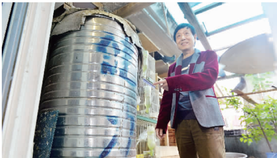
融城花苑小区21栋701室的崔琳自建水塔防停水。
