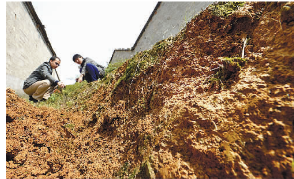
4月28日上午,长沙市芙蓉区东湖街道工作人员在北宋古城墙遗址进行现场勘查。 记者 徐行 通讯员 尹卫东 摄
