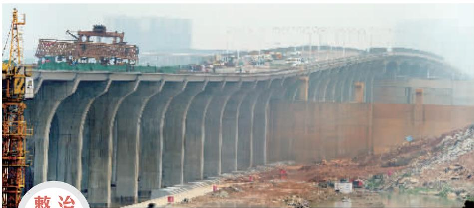
4月17日，湘江长沙综合枢纽三期工程桥梁主体完工，计划6月实现贯通。坝顶公路桥总长1944米，双线六车道。桥坝合一，长沙今年也将因此新增一条过湘江通道。
