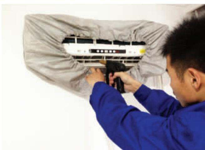
高压水枪冲洗空调明显的灰尘污垢。
