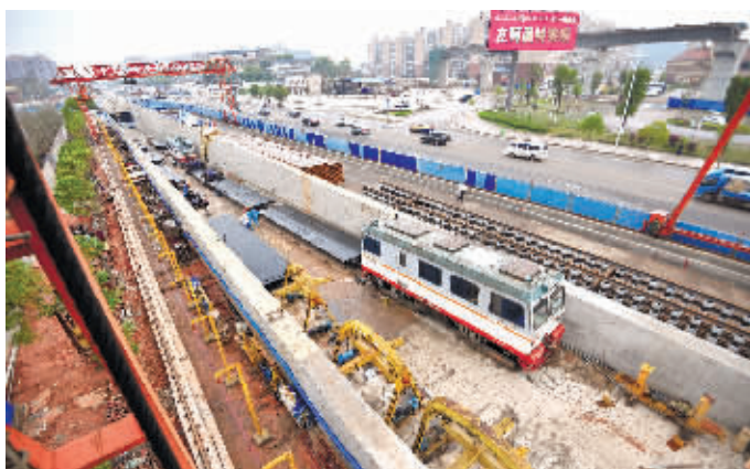
3月26日下午,长沙市地铁1号线中信广场站建设工地,铺轨设备及材料已进场。 记者 田超 实习生 李梦 摄
