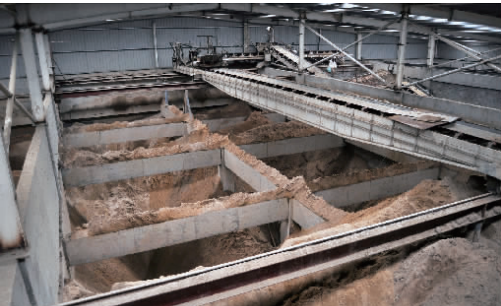
17日下午5点，操作区内一名员工在维修时不小心被沙子淹没遭遇不幸。2月18日，长沙芙蓉北路泽禹混凝土公司操作区内一片寂静。 记者 李健 摄
