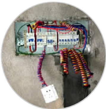
久的二手房,房屋很可能存在电路分配简单、电线老化、违章布线等现象,已不能适应现代家庭的用电需求,所以在装修时要彻底改造,重新布线。
