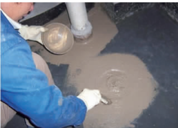
96258的房屋修缮师傅在赵先生家施工。
