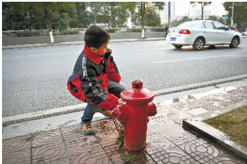
2013年12月31日下午,长沙市银双路,10岁的谢元晟向记者讲述当时消防栓漏水的情景。 实习记者 李健 摄
