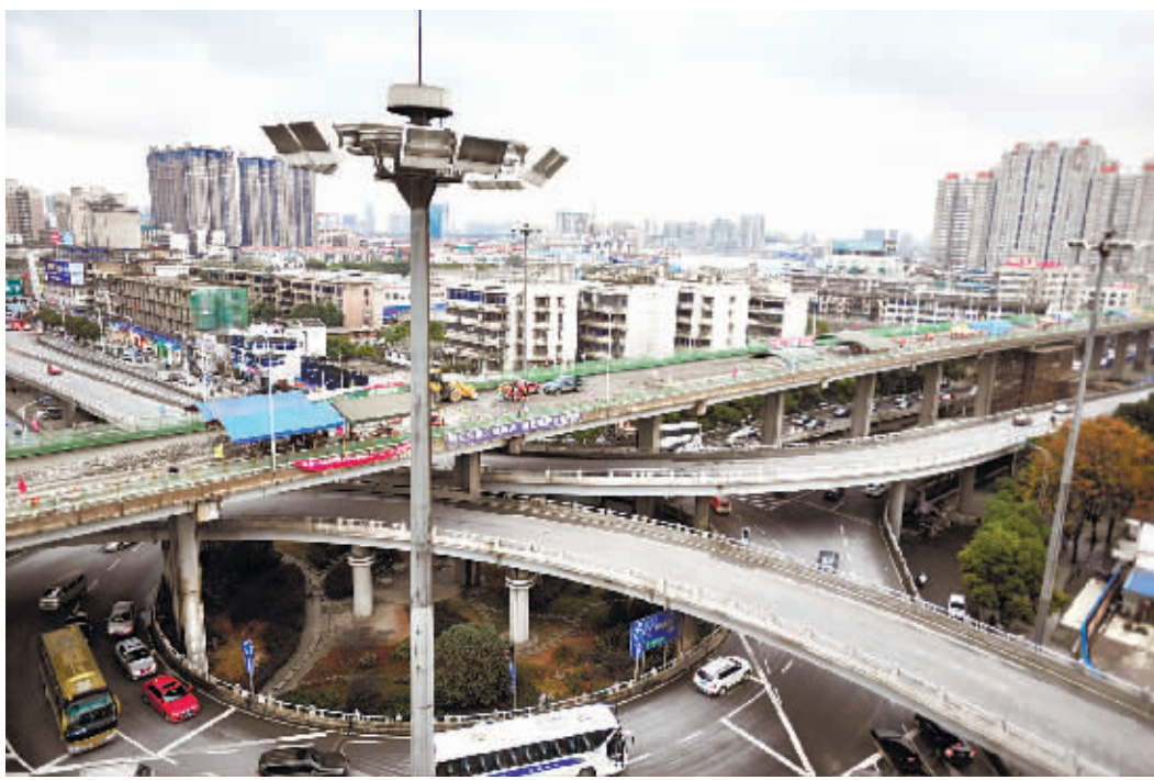
12月17日下午，长沙市东二环，由长沙市路桥征费维护管理处组织的工人们正在抢修团结路立交桥。
