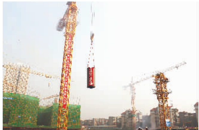
直径近两米、重达九吨的巨型钢柱被徐徐吊起。
